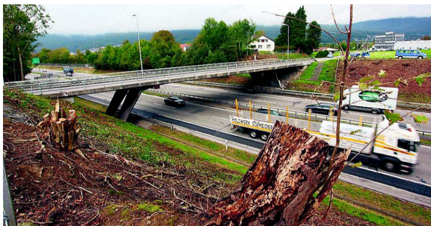
In diesem Bereich wird in den nächsten Wochen eine 56 Meter lange Notbrücke aufgebaut. HR. AESCHBACHER
